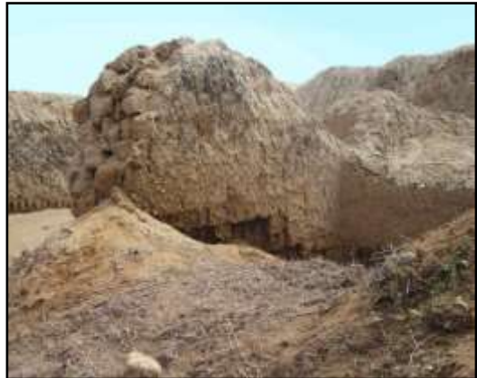
Fig. 12. Véase como las plantas que habían evitado el asoleamiento, llegaron a influir gravemente en la erosión del muro. (S.O. de UHle)
