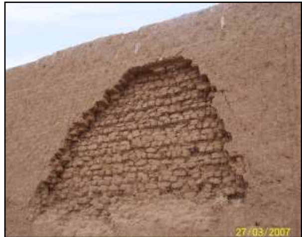
Fig. 17. El paño hecho con adobes sin engranar con los del interior, terminaba por descolgarse, en la menor falla de las hiladas inferiores. Pronto caería la parte alta.
