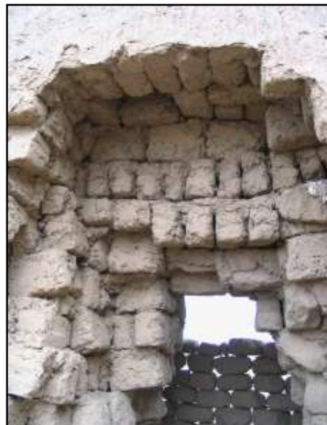
Fig. 15. Los adobes de arriba ya se caían. Había que cimentar y armar desde abajo.
