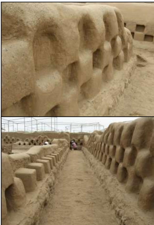
Fig. 19. Diferencias de concepto en la restauración de estos escaques, en volumen y en buen gusto. En ambos casos se ha exagerado, a unos le han dado una cubicación muy fuerte y rígida y a los otros los han “almohadillado” o “bombeado”. En Nik An, las figuras romboidales, de tanto intervenirlas las convirtieron en óvalos. Todo esto ya fue corregido.
