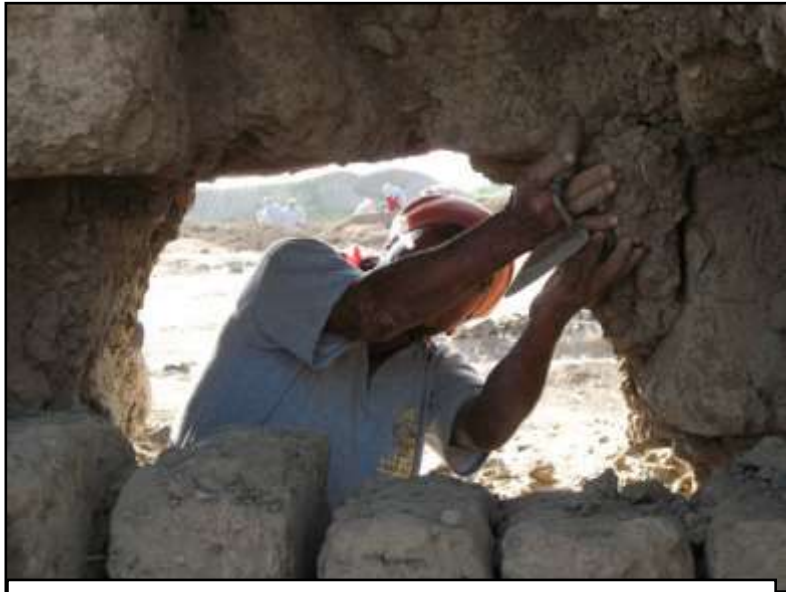
Fig.20. Una horadación de lado a lado en un muro, implica acciones más cercanas a la nueva cimentación para que el muro ya no siga desplomándose. En varios casos, se caían los adobes de la parte alta, solamente por gravedad y falta de mortero en la “llaga”.
