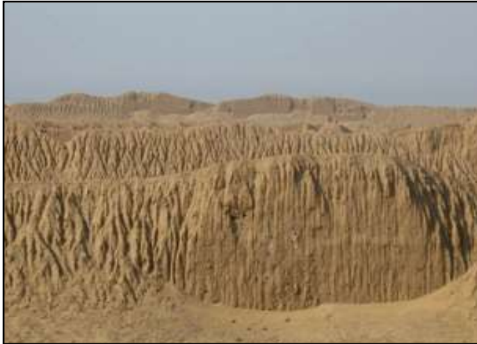
Fig. 8. Ver las “torreteras” y el diverso efecto de las lluvias los en diferentes muros. A unos los destruye y a otros no. (Ñaing An).
