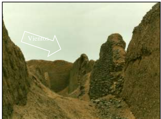
Fig. 13. Véase como lo vientos húmedos afectaron el muro oeste que recibía ese embate, desde la base hasta las partes altas. (Chol An, Rivero).
