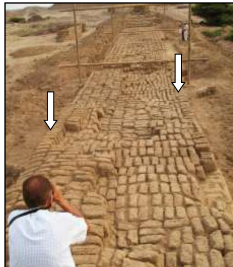
Fig. 16. Las flechas señalan la forma en que los adobes fueron puestos en los bordes, sin engranarlos con los del interior.
