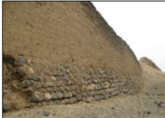
Fig. 14. En este muro, se observa que los cimientos fueron rehechos y luego se los enchapó con piedra y arcilla. En el interior se usó piedras de menor tamaño.
