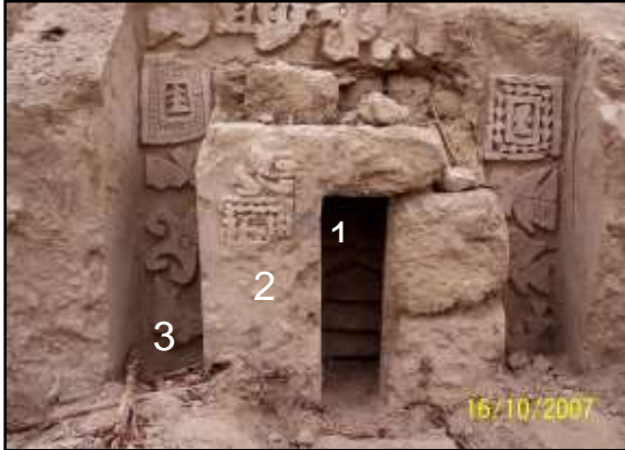
Fig. 7. Tres restauraciones superponiendo frisos. 1, el más fino. 2, la “U” invertida y 3, el relieve menos prolijo.
