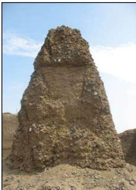
Fig. 8. Muro interior de Rivero hecho con hormigón prensado a manera de tapia.
